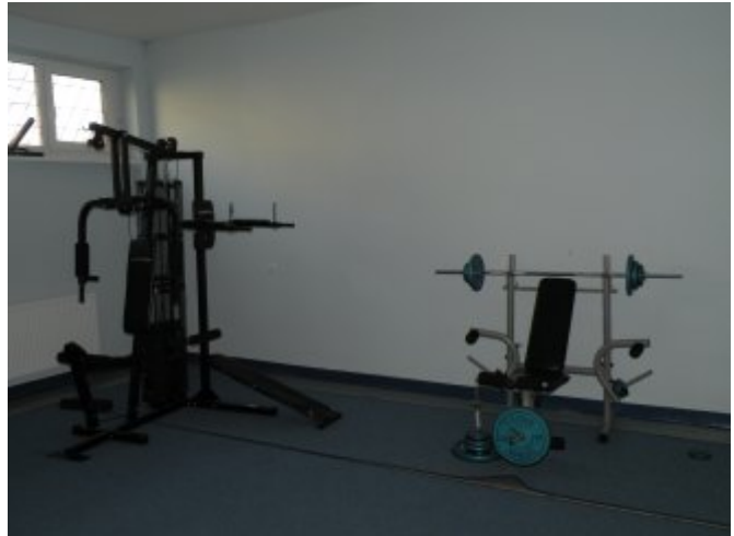
Wyremontowane pomieszczenie siłowni
