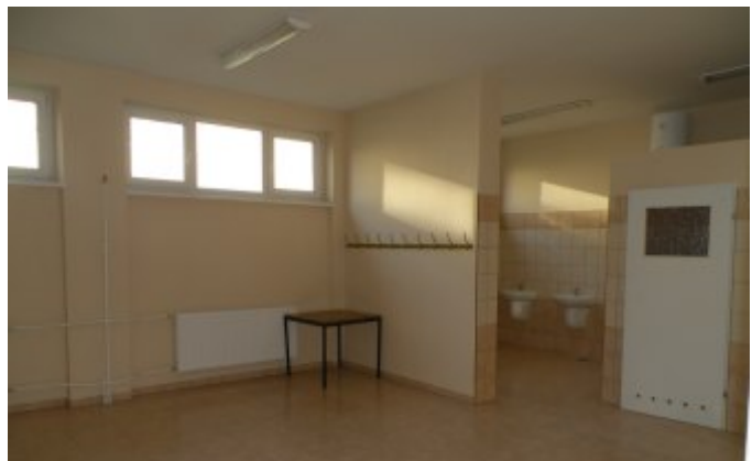
Wyremontowane zaplecze szatniowo - sanitarne
